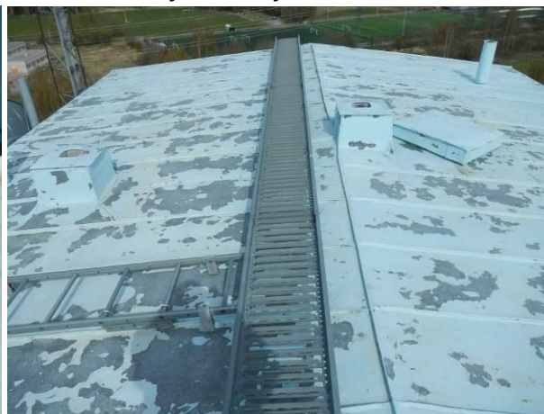
Kuvat 26 ja 27. Rakennuksen 3ABC ylemmän katon harjasaumojen maalaus lohkeilee paikoitellen ja pellissä on pieniä ruostuneita alueita. Rakennuksen 4CD ylemmällä katolla on alue, jossa maalaus lohkeilee voimakkaasti.
