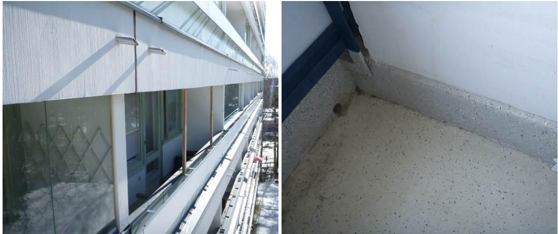
Kuvat 18 ja 19. Parvekkeiden yleisilme on hyväkuntoinen. Osa parvekkeista on lasitettu. Kaiteiden, pieliseinien ja parvekelaattojen pinnoitteet ovat tyydyttävässä kunnossa.
