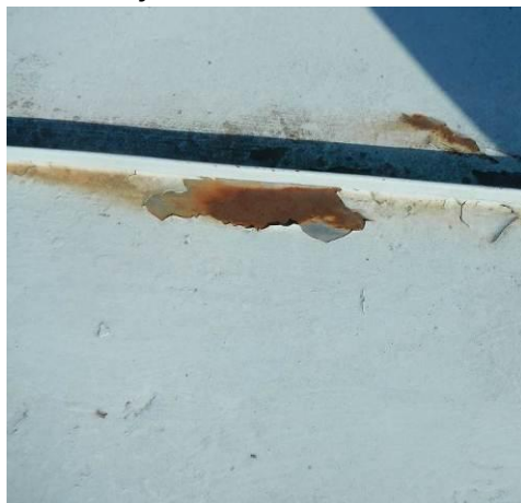
Kuvat 26 ja 27. Rakennuksen 3ABC ylemmän katon harjasaumojen maalaus lohkeilee paikoitellen ja pellissä on pieniä ruostuneita alueita. Rakennuksen 4CD ylemmällä katolla on alue, jossa maalaus lohkeilee voimakkaasti.
