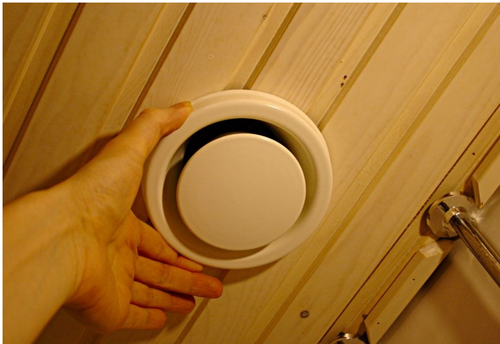
Kuva 1: Poistoventtiilin avaaminen puhdistusta varten.
